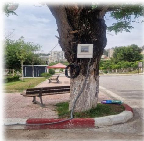
**Photo 23 :** Compteur d'électricité et câble électrique exposés.
